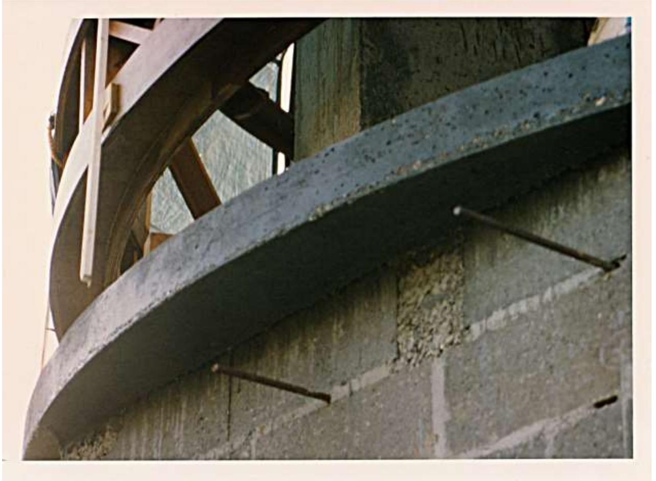
L'abri tourne sur 10 roulettes de largeur 40 mm et de Ø 190 mm. Elles sont recouvertes de caoutchouc afin d'éviter les grincements pendant la nuit.
