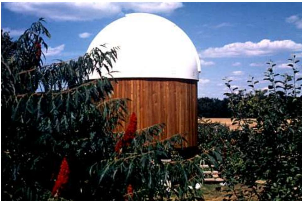
La coupole en résine de 3 mètres de diamètre.
