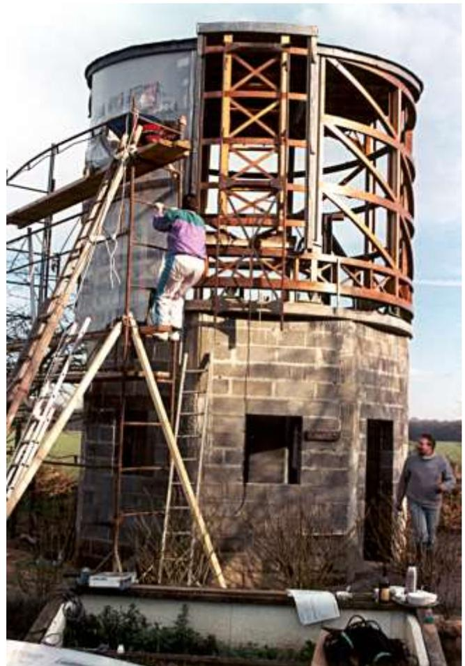
Pose du plancher à 3,5 mètres de hauteur ; fixation de l'escalier.
