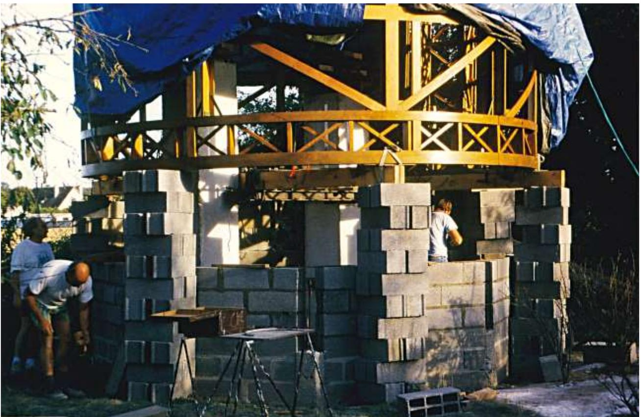
Chemin de roulement de l'abri : épaisseur du béton:10 cm avec un ferrailage particulier type " balcon".
