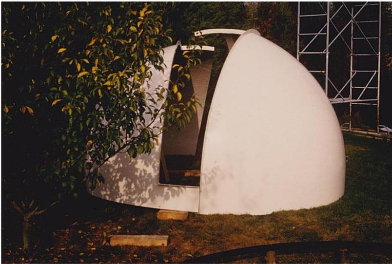
La coupole une fois assemblée, a été recouverte d'un gelcoat blanc afin de limiter la chaleur du soleil à l'intérieur de l'abri.
