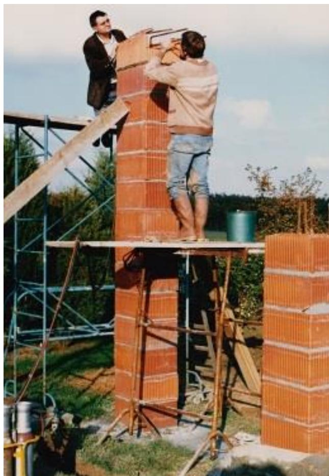
Ces 2 piliers reposent sur des plots en béton ancrés dans le sol de section 1 m x 1 m x 1 m et reliés entre eux par une "poutre" en béton de 60 cm x 60 cm. Sortant de chaque plot, 4 fers à béton de 16 mm, ont servi à empiler les boisseaux de cheminée.
