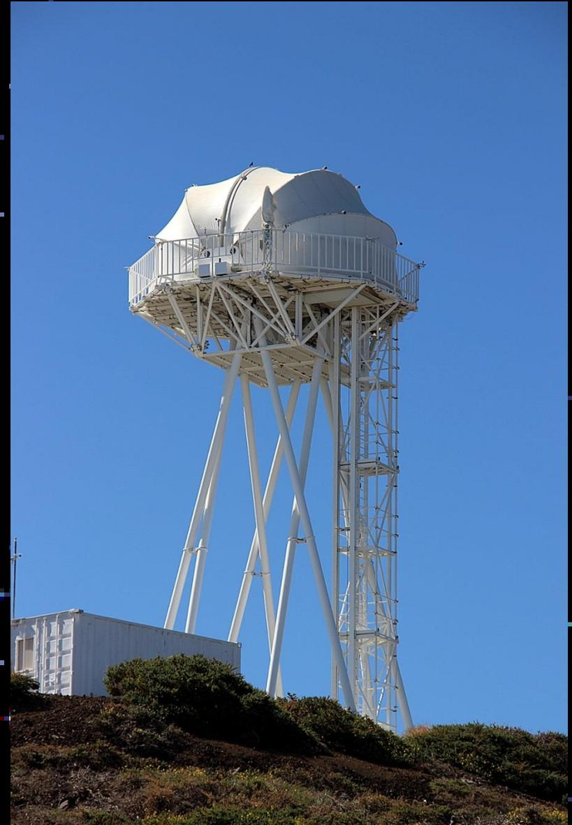
**Télescope Solaire Hollandais (DOT)**: tour de hauteur 15 mètres. Le miroir a un diamètre de 45 centimètres.
